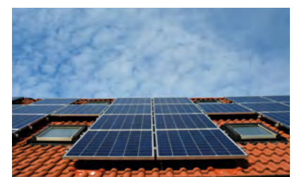
Sonnenenergie vom Dach.
